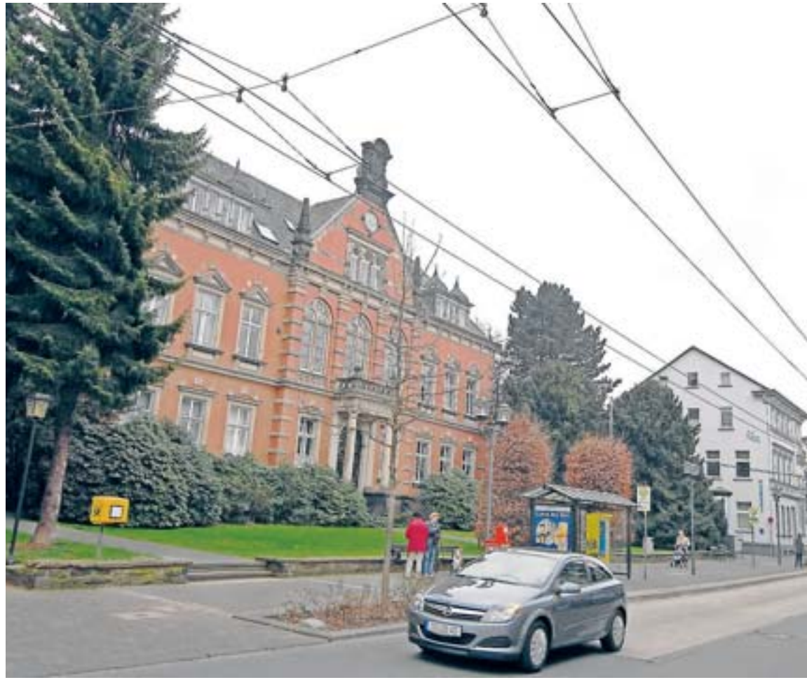
Das ehemalige Walder Rathaus an der Friedrich-Ebert-Straße ist vom Investor Planbau Schwaben zum Bürocenter „Smart up“ umgestaltet worden.
